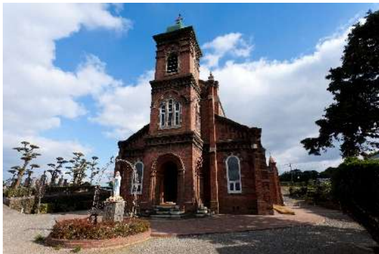
田平天主堂（国指定建造物）
