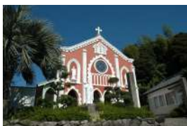
宝亀教会 （県指定建造物）
